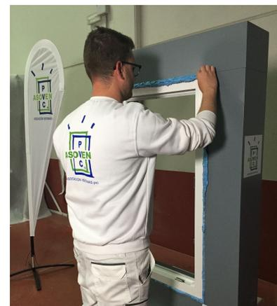
En el caso de la espuma de poliuretano PU flexibles hay que garantizar su durabilidad y esta relacionada con la buena adhesión de la espuma, la correcta protección a los rayos UV y su capacidad para absorber los movimientos de cerca y obra. Se debe de humedecer con agua previamente a la pared y la ventana para favorecer su aplicación.
