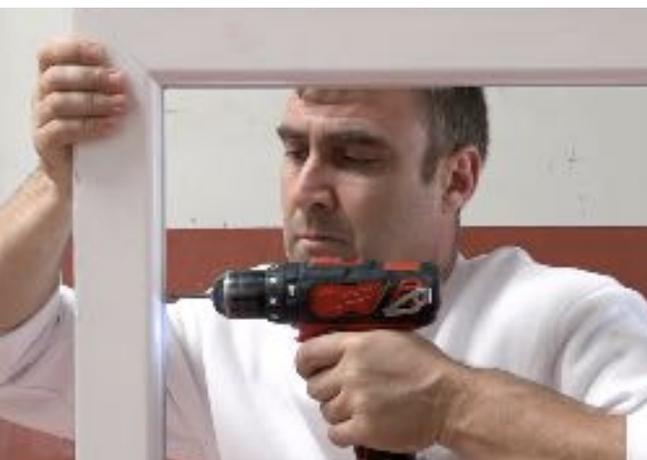
**El instalador de los herrajes debe seguir fielmente las indicaciones o prescripciones facilitadas por el fabricante de los herrajes, limpiando ranuras, piezas, apretando los tornillos y engrasando las uniones.**
