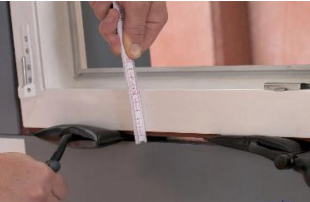
La misión de los elementos de fijación es inmovilizar y unir la ventana a la estructura de anclaje (precerco, etc.) colocada previamente en el muro o directamente al soporte resistente.
